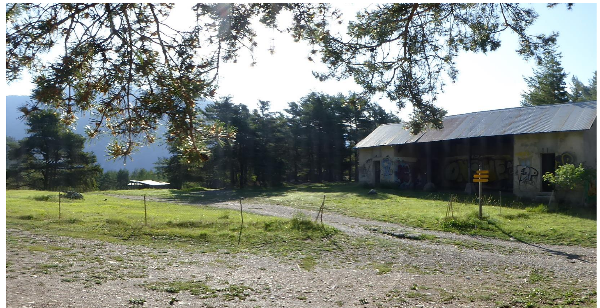
Bâtiment existant et conservé
