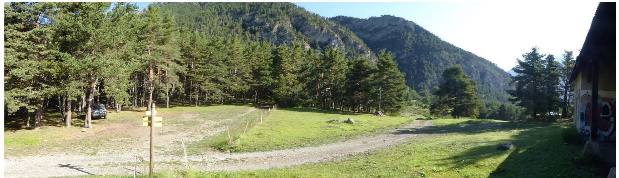
Depuis le sud, en arrivant sur le plateau : bâtiment existant conservé et entrée principale du projet
